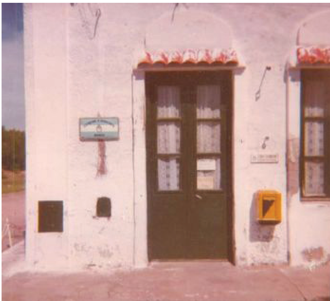
Imagen 6. Estafeta postal. Atrás vivienda de Carmen Pipitó.
